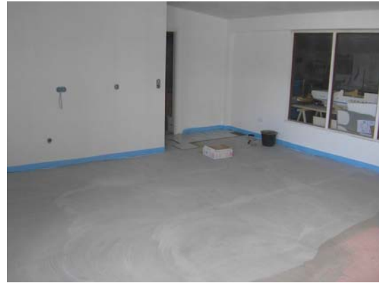
Die ersten drei Fliesen sind gelegt
